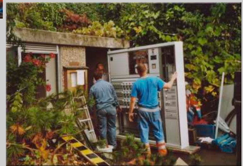
Trafostation Hüsler Umbau 2005
